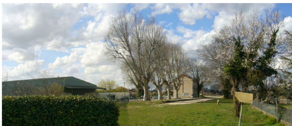
11. Arrivée sur le site depuis l'est par la Via Venaissia
