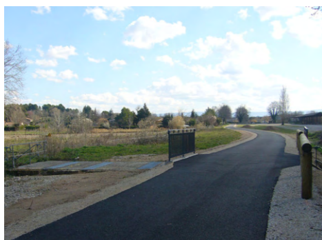
1. Passage de fossé d'irrigation sous la Via Venaissia à l'entrée ouest du site
