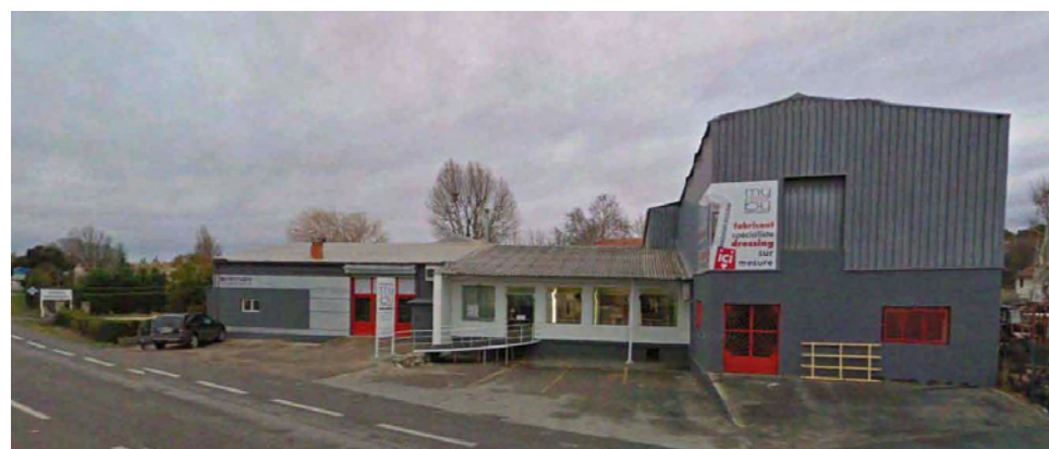
7. Front bâti vu depuis la RD 950
